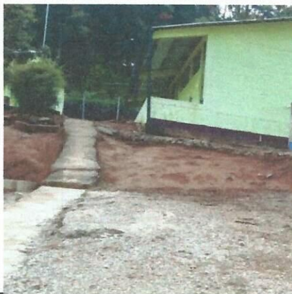
Foto 4: LOSA DE PATIO
