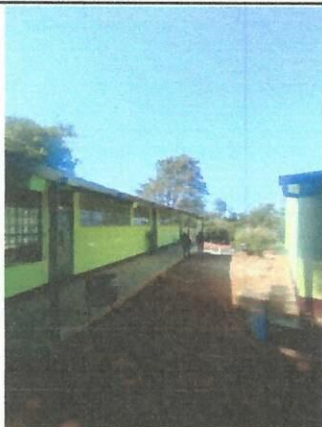
Foto 1: TECHADO DE PATIO
