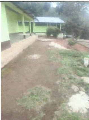
Foto 3: LOSA DE PATIO
